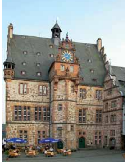
Im Marburger Rathaus (erbaut 1512-27). Dietrich Ernst war 1581 Unterbürgermeister, als der markante Uhrengiebel über dem Trepenturm errichtet wurde.
