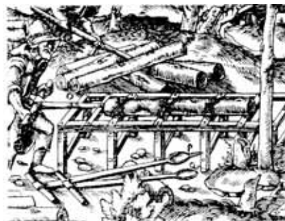
Holzstämmen werden mit einem Löffelbohrer zu Wasserröhren ausgehöhlt – eine Tätigkeit, die zu den häufigsten für Ludwig Ernst gehörte. Aus: Georgius Agricola: De Re Metallica, 1556.
